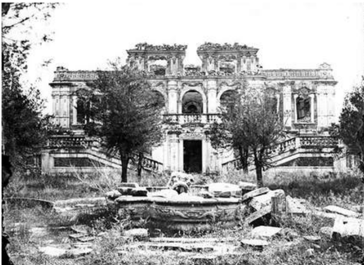
Uno dei Palazzi Occidentali dopo il 1860
