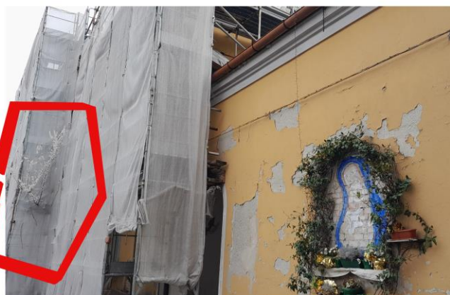
PIAZZALE DI PORTA MODENA LATO SUD
